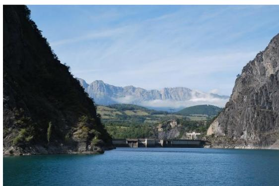
La retenue d'eau permet la production d'électricité mais aussi la régulation du débit d'eau de la rivière Drac (le niveau de l'eau pouvant varier de 0 à moins 40 m en hiver).
